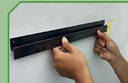
1. กำหนดระดับที่ต้องการติดตั้ง โดยใช้ Hanging Bar วางทาบและมาร์คจุด
