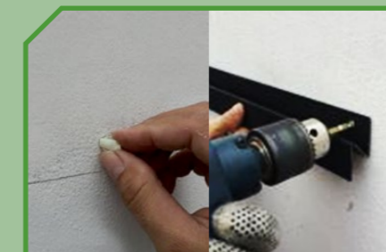
3. ตอกพุกและขันสกรูติดตั้ง Hanging Bar
